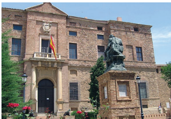
Fig. 15. Casa en Viso del Marqués de Don Álvaro de Bazán.
