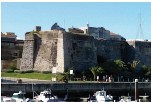
Fig. 8. La Fortaleza de Nuestra Señora de la Luz. Era un componente fundamental del sistema defensivo de Cascais.
